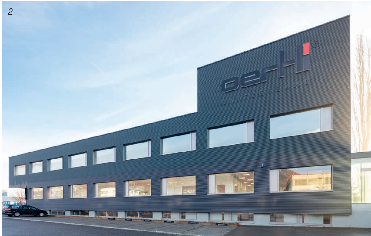
2 Gebäudeaufstockung mit 1'200 m 2 Während der Erweiterung wurde die Produktion in den Reinräumen fortgeführt.
